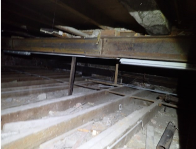
Bilder 7 und 8: Übersicht: Stahlträger und Sprengwerke (Nadelholz) bilden das Deckentragwerk
